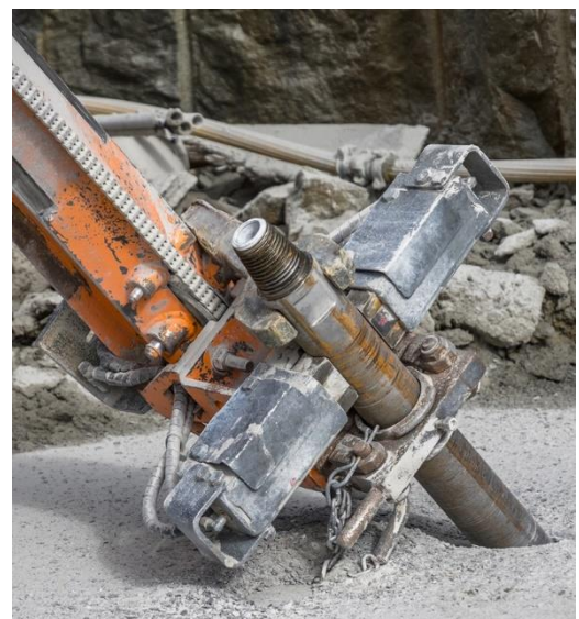
Figura 7 – Foro operato dalla perforatrice idraulica, dettaglio del bloccaggio delle aste di perforazione in attesa di un nuovo innesto.
